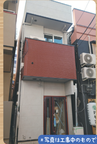
*写真は工事中のものです。
