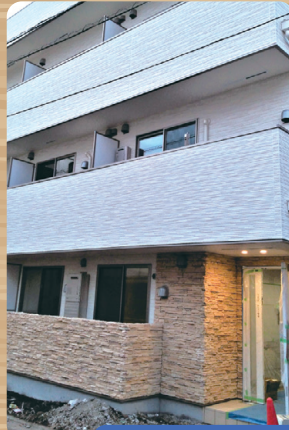
*写真は工事中のものです。
